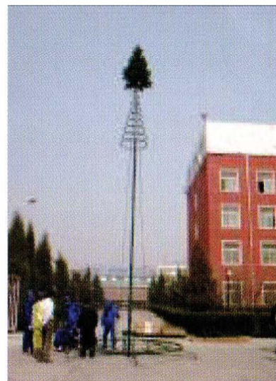
Fase 3 Collegare la parte superiore dell'albero
