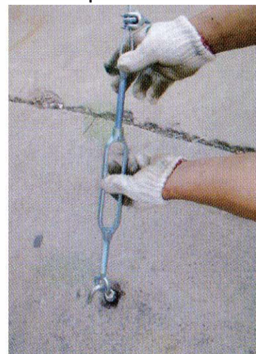
Fase 6 Avvitare i cavetti guida al pavimento
